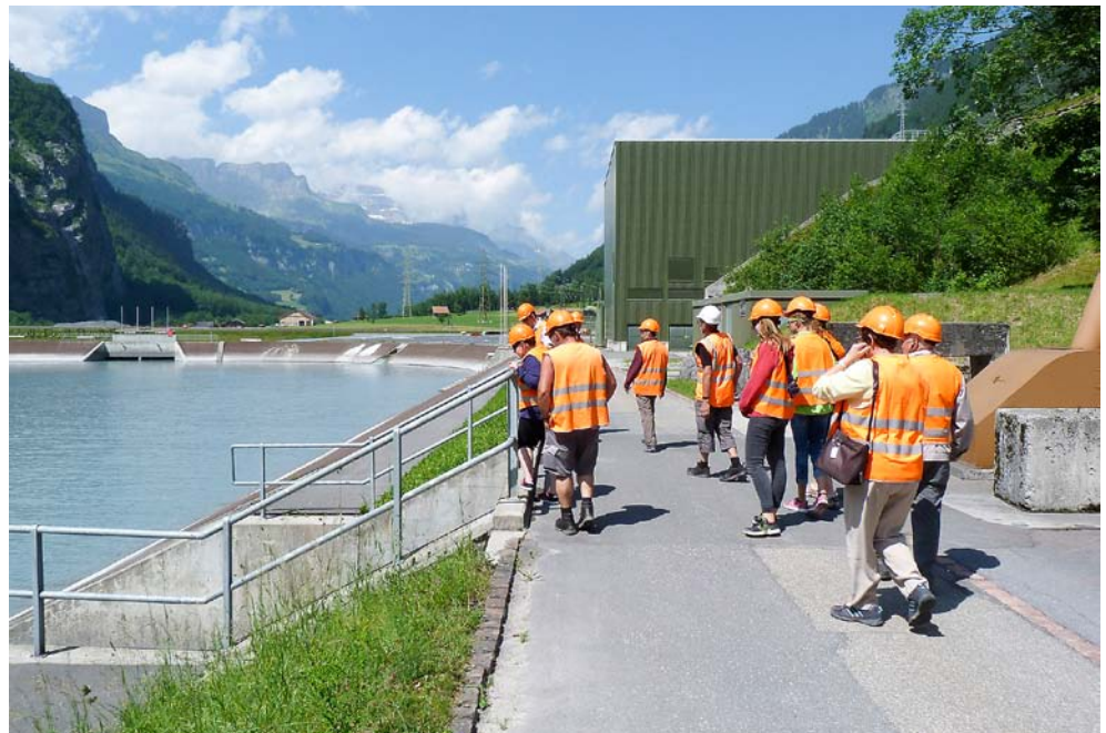
Während des Rundgangs: am Ausgleichsbecken vorbei zur Schachtzentrale mit dem Pumpspeicherwerk. Bild: Karl Oberholzer
